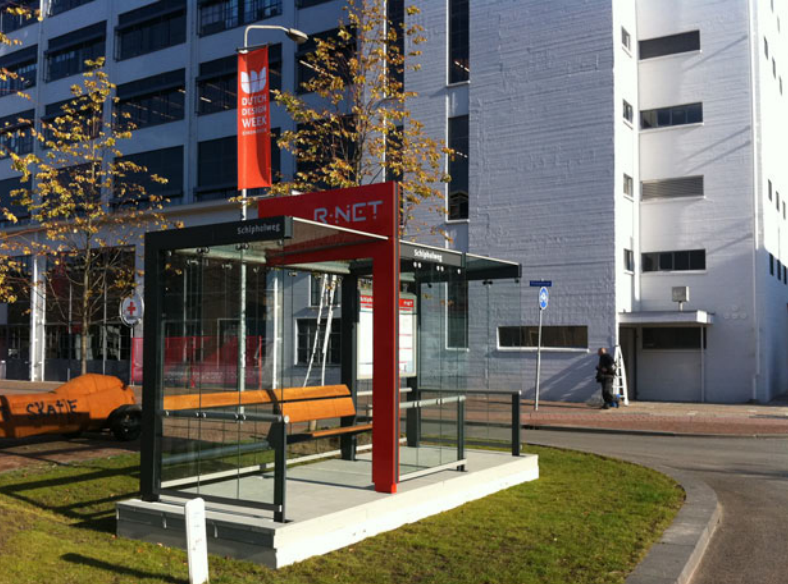
Tijdelijke opstelling R-net halte in Eindhoven
